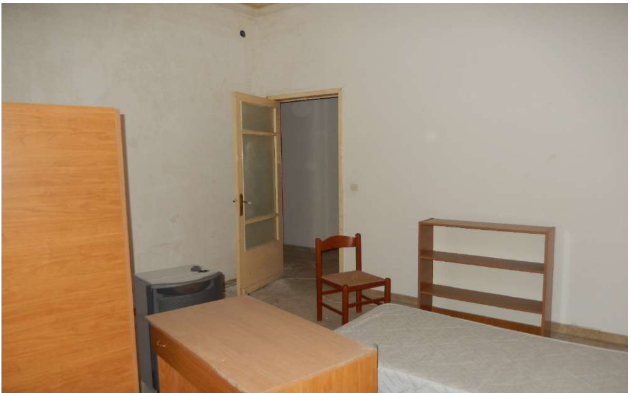
FO L1-22: particolare vano "3";
