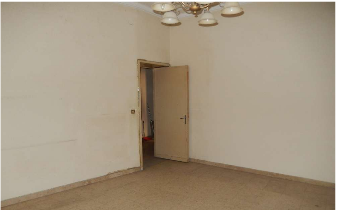
FO L1-76: particolare vano "2";
