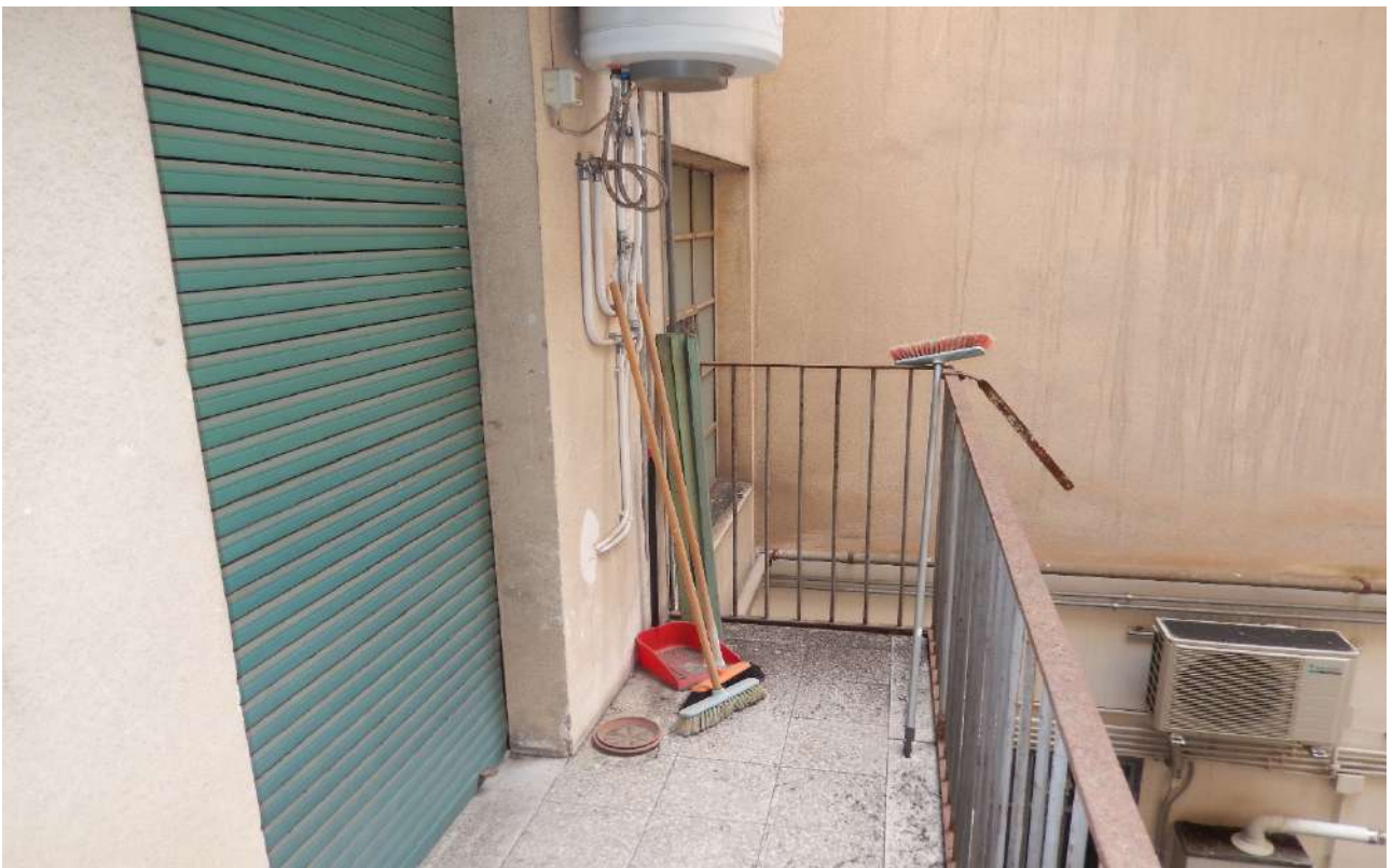
FO L1-30: ballatoio prospiciente il vano cucina ed il vano "3", con affaccio su cortile interno;
