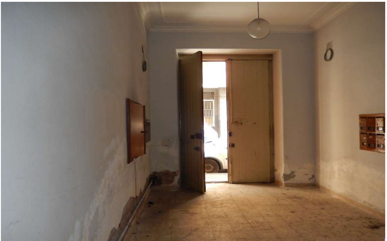
FO L1-6: androne condominiale;
