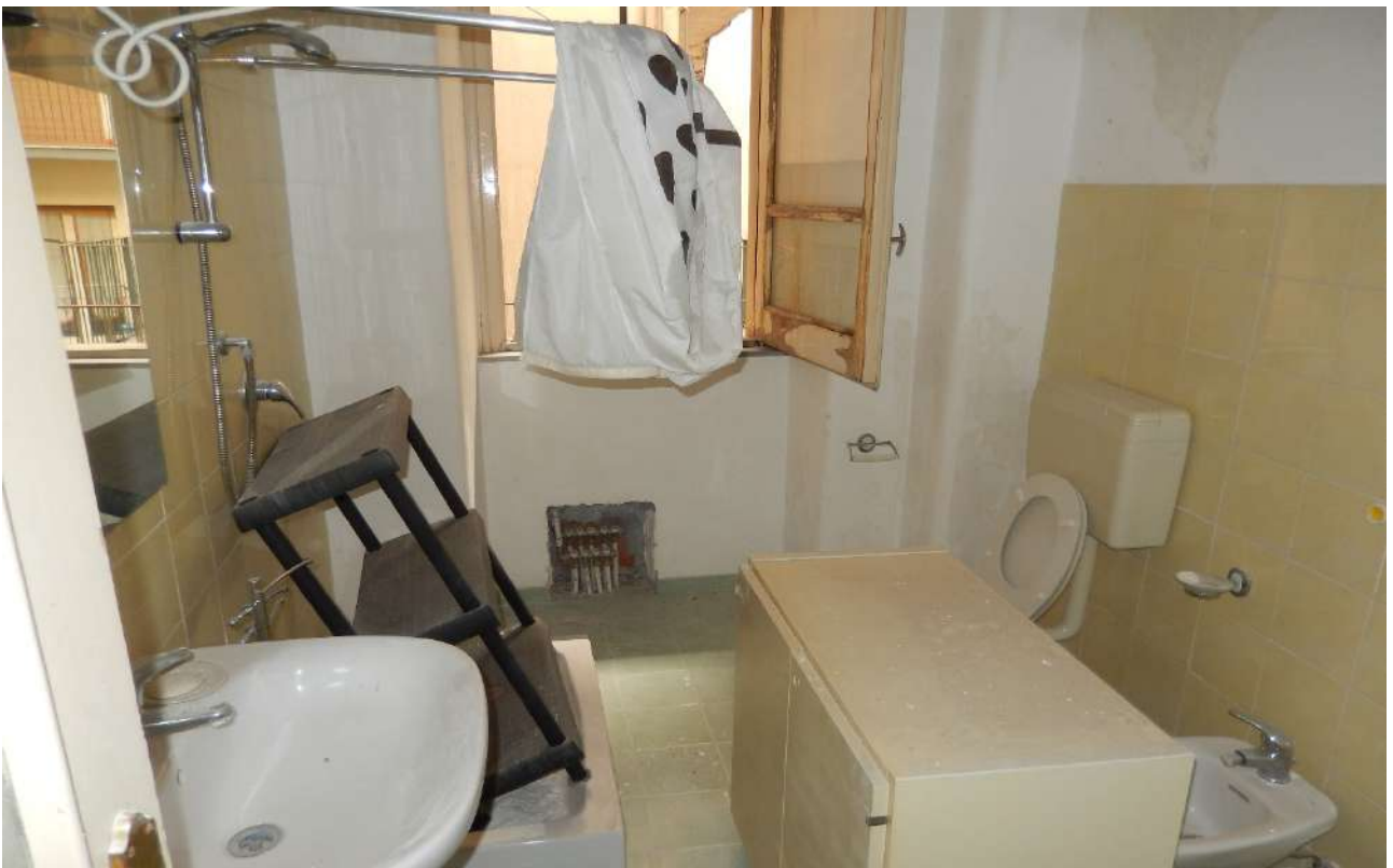
FO L1-26: particolare bagno;
