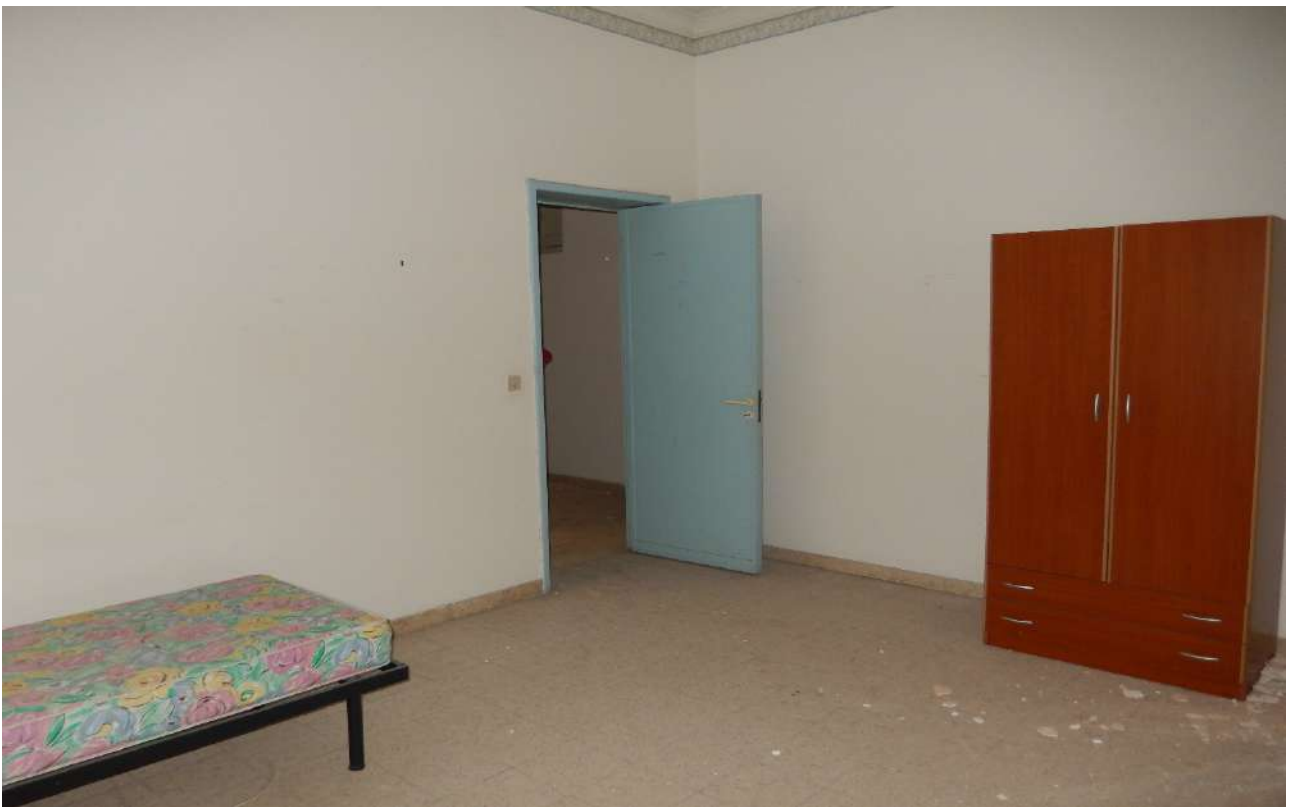
FO L1-94: particolare vano "2";
