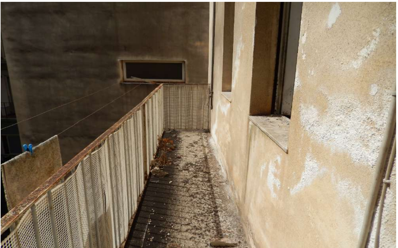
FO L1-100: ballatoio con affaccio su cortile interno;
