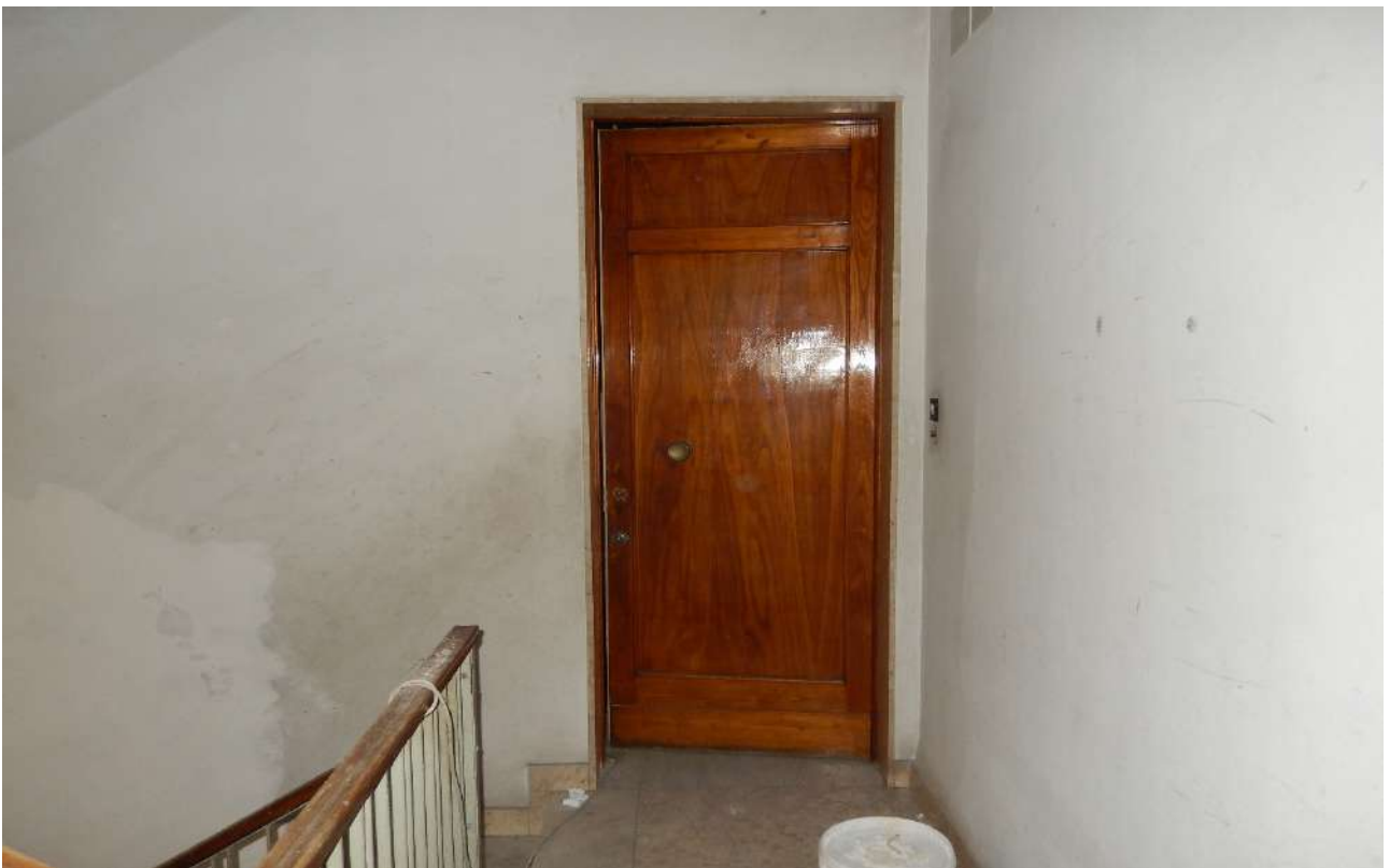
FO L1-12: pianerottolo condominiale e porta d'ingresso;
