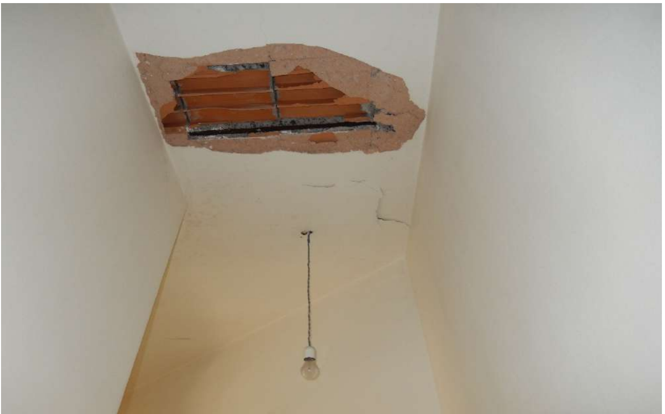
FO L1-90: particolare soffitto disimpegno;
