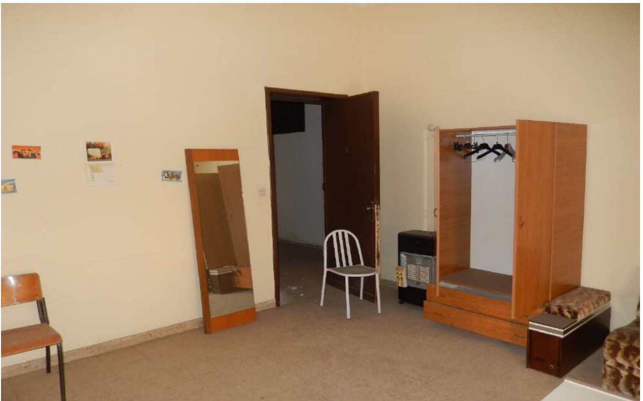
FO L1-56: particolare vano "2";
