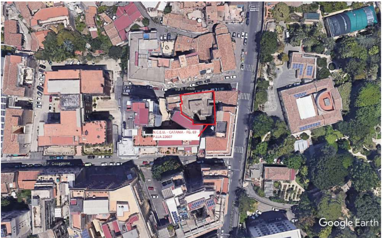
FO L1-1: veduta aerea edificio in Catania, Via Raimondo Feletti n.11;
