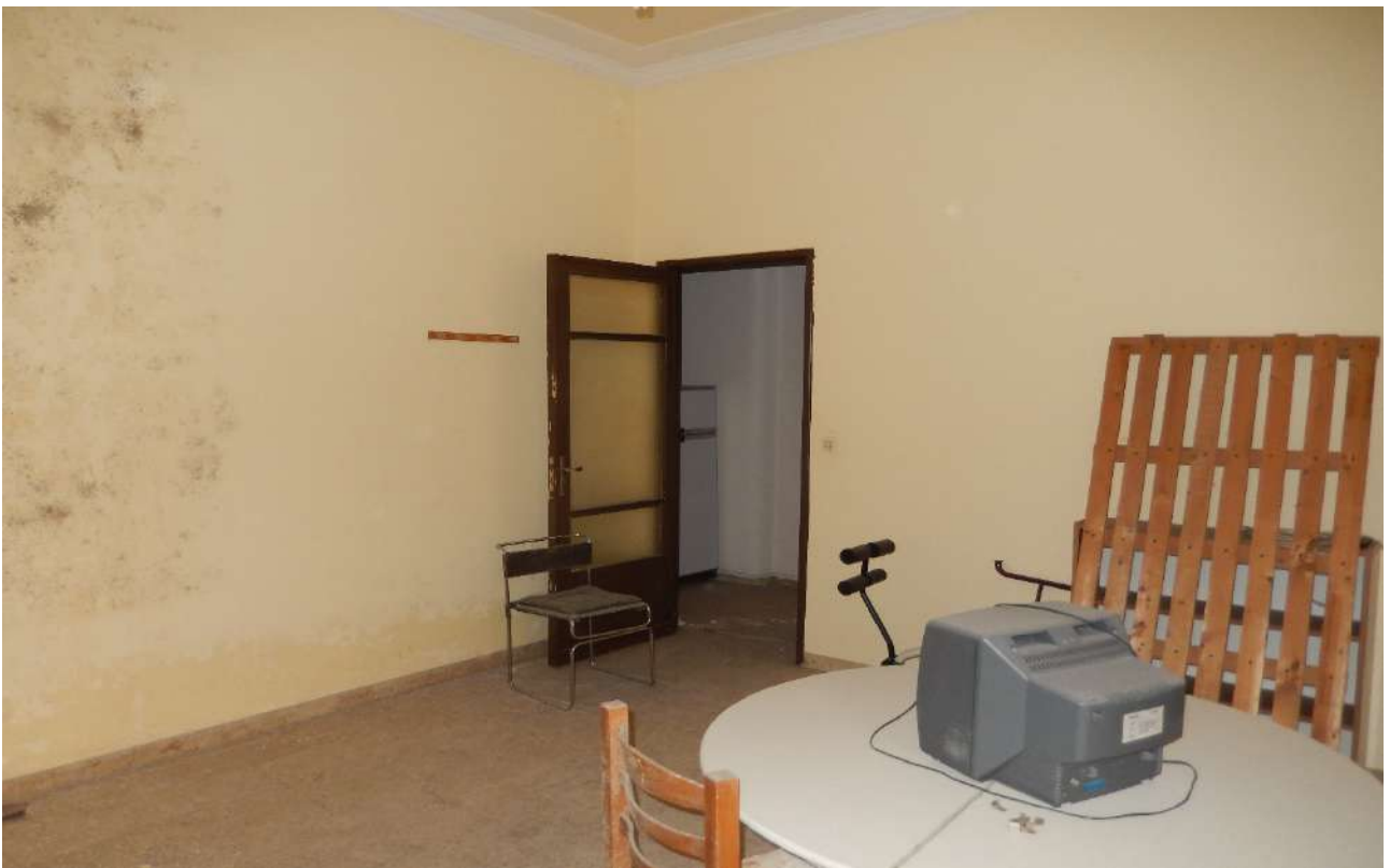
FO L1-58: particolare vano "3";
