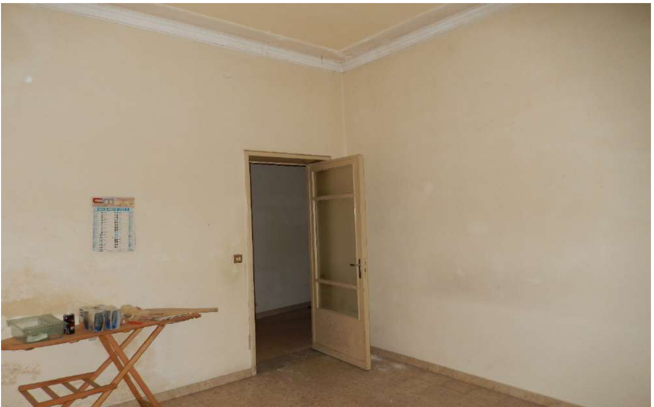
FO L1-78: particolare vano "3";
