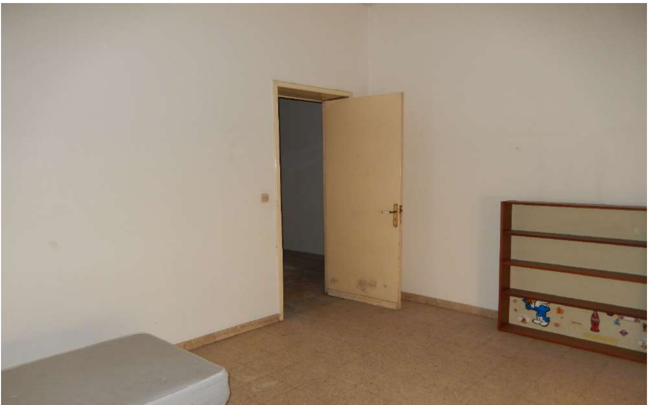
FO L1-20: particolare vano "2";
