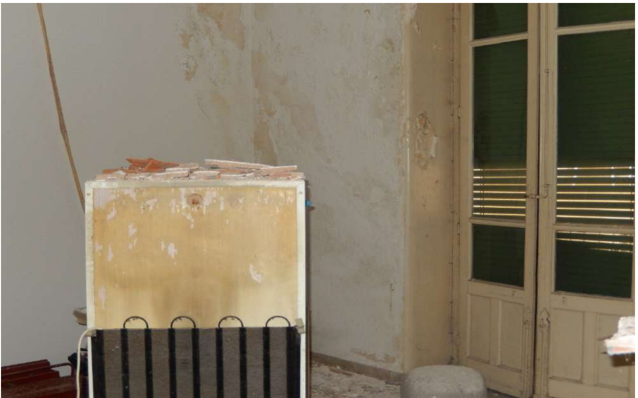
FO L1-112: particolare vano "3";
