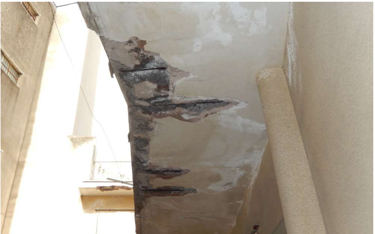
FO L1-86: particolare ballatoio interno;
