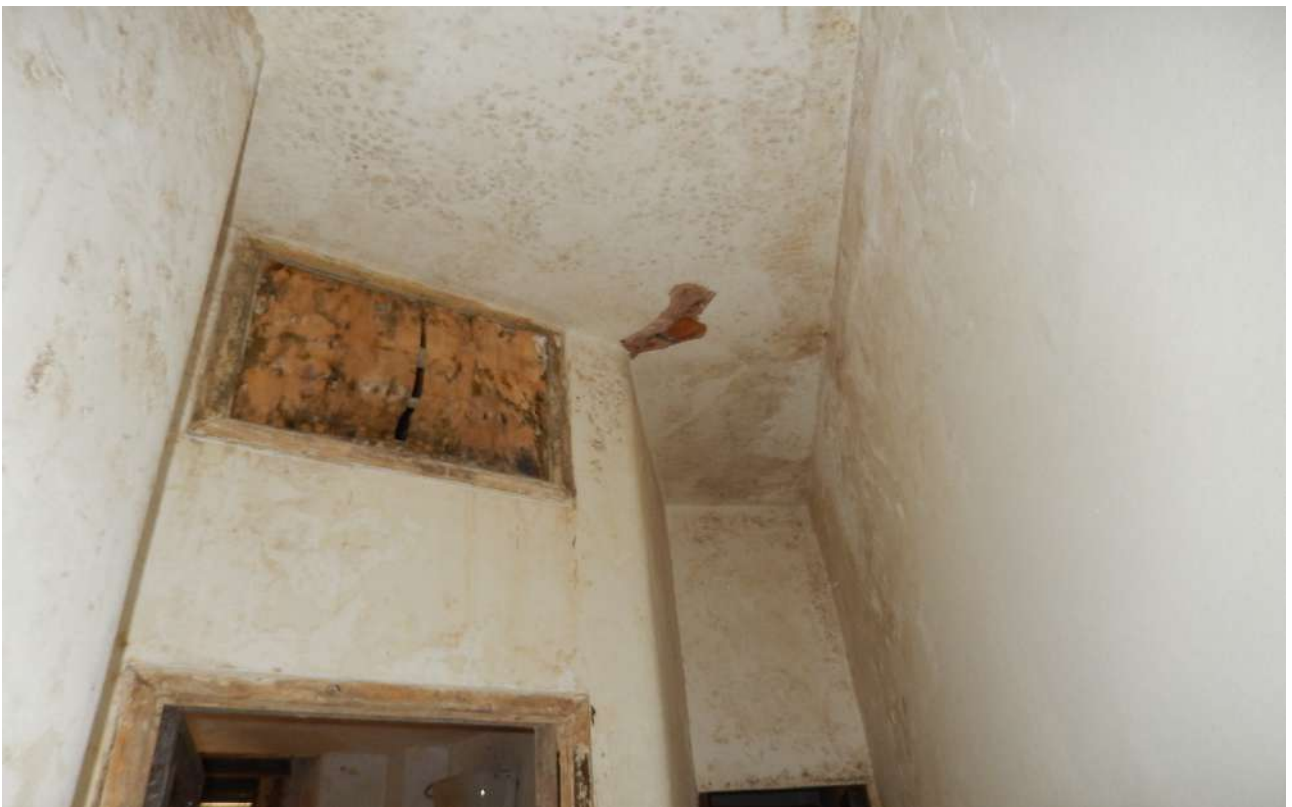
FO L1-52: particolare disimpegno;
