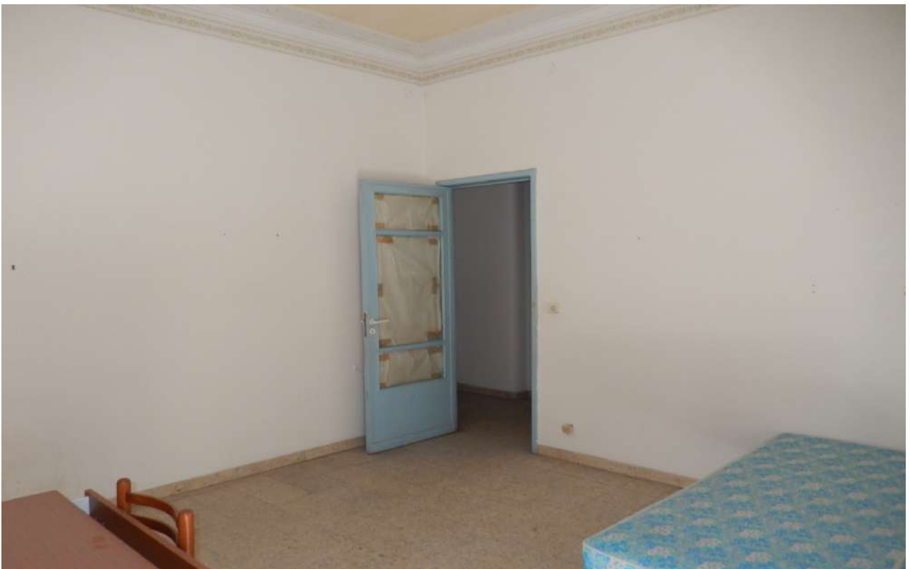
FO L1-96: particolare vano "3";
