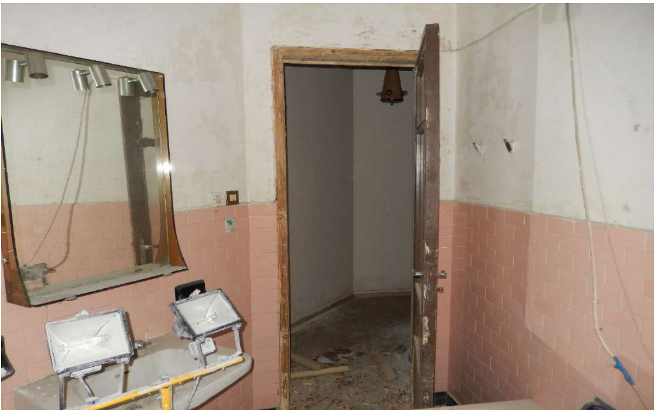
FO L1-62: particolare bagno;
