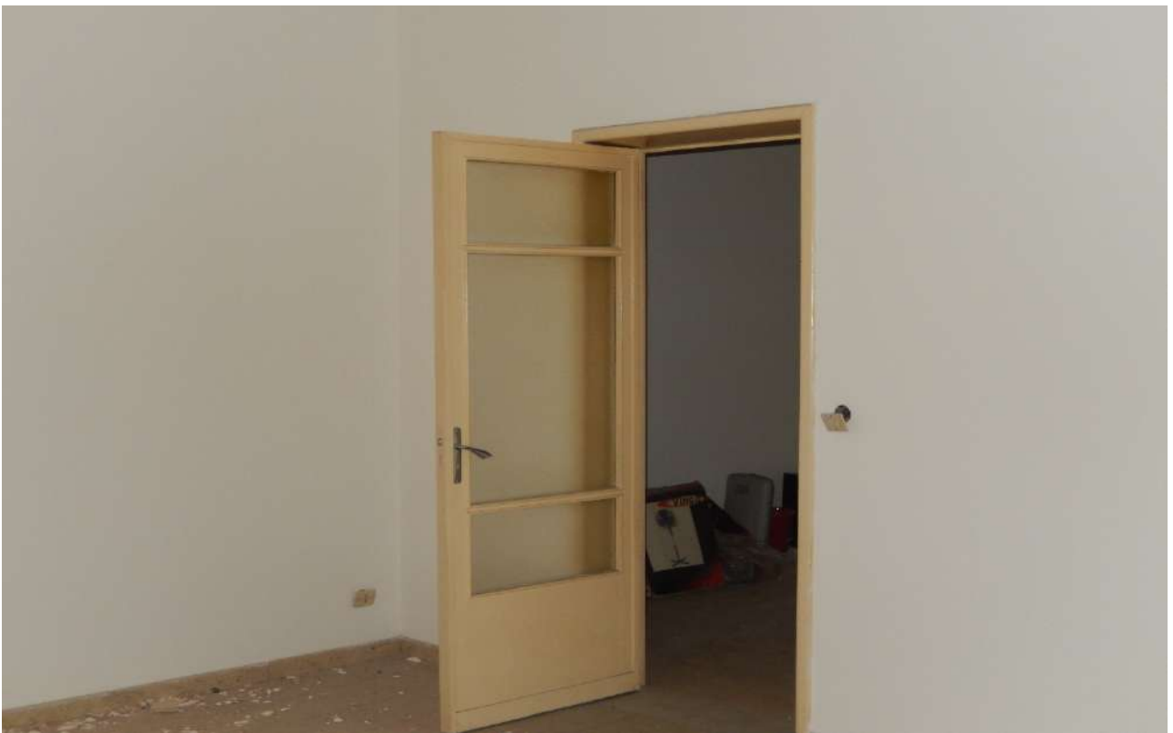
FO L1-106: particolare vano "1";
