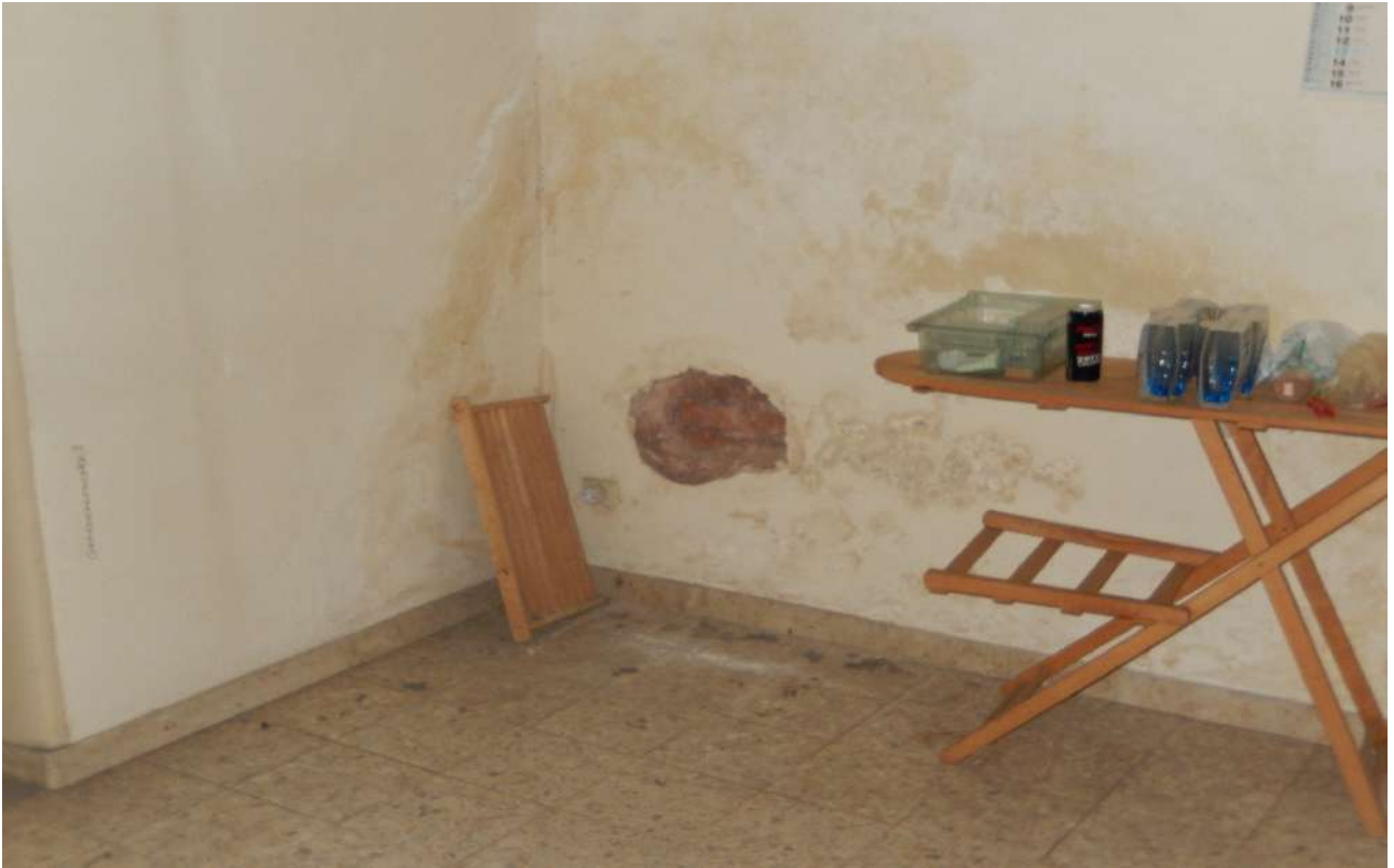
FO L1-79: particolare vano "3";
