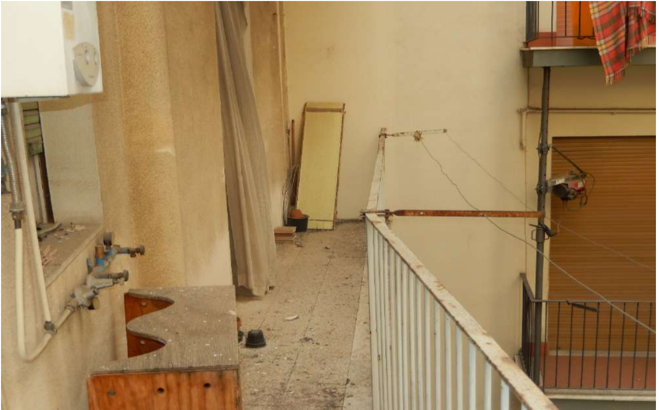
FO L1-85: particolare ballatoio interno;
