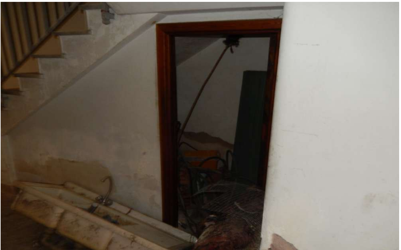
FO L1-10: ripostiglio – sottoscala condominiale;
