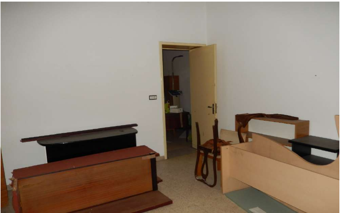
FO L1-38: particolare vano "2";
