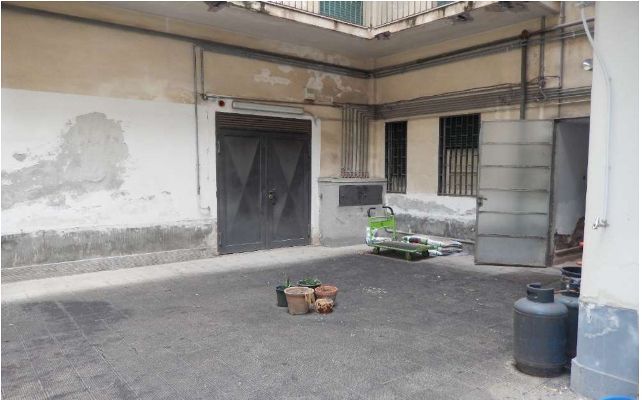
FO L1-9: particolare cortile interno;
